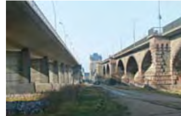
Die neue und die alte Nibelungenbrücke
