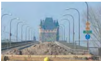
Sanierungsarbeiten an der alten Nibelungenbrücke. Blick auf den Nibelungenturm
