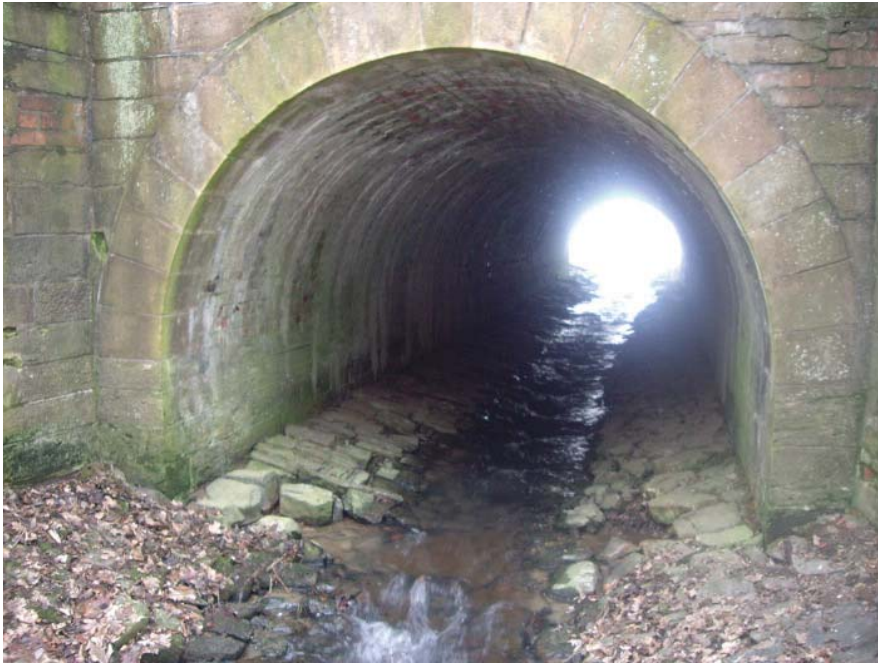
Abbildung 21: Bach-Unterführung U6 Daisbach Bahnlinie/ Niederseelbach.
