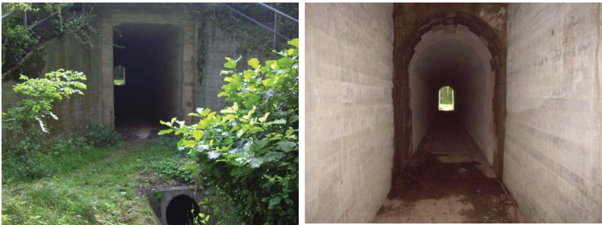
Abbildung 19: Fußweg-Unterführung U3 Waldhof A 3/ Niederseelbach.
