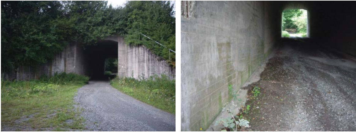
Abbildung 18: Forstweg-Unterführung U2 Engenhahner Pfad.
