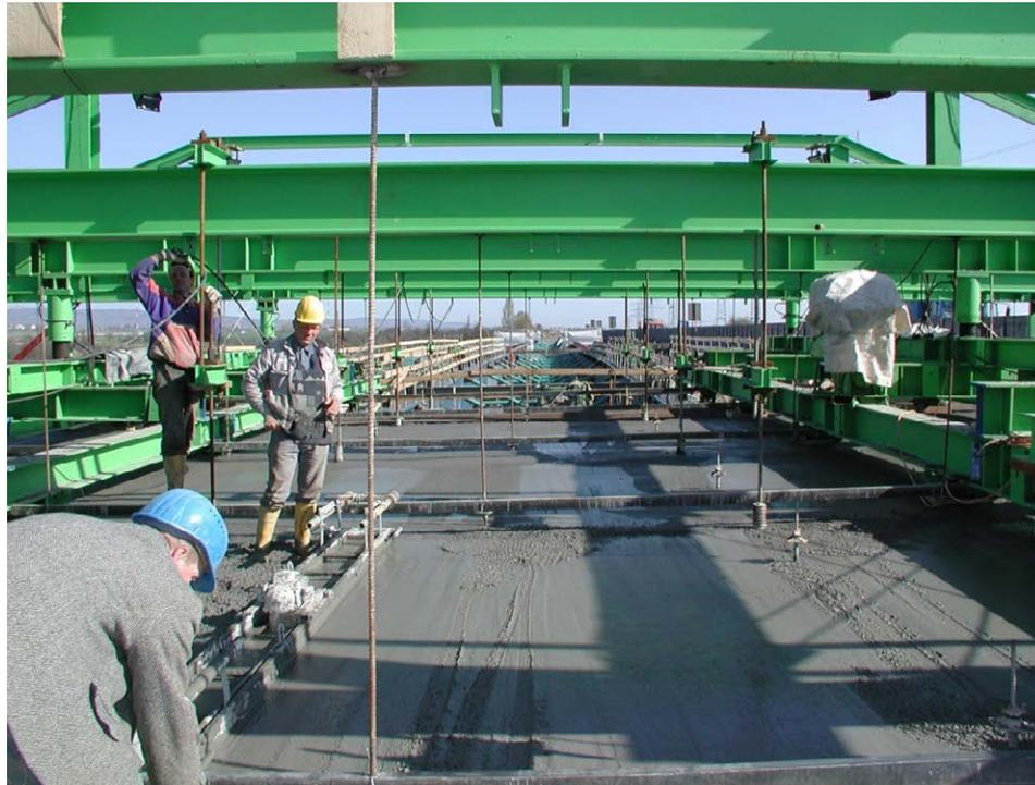
Bild 4.3.1: Abziehen der Fahrbahnplatte der Urselbachtalbrücke
