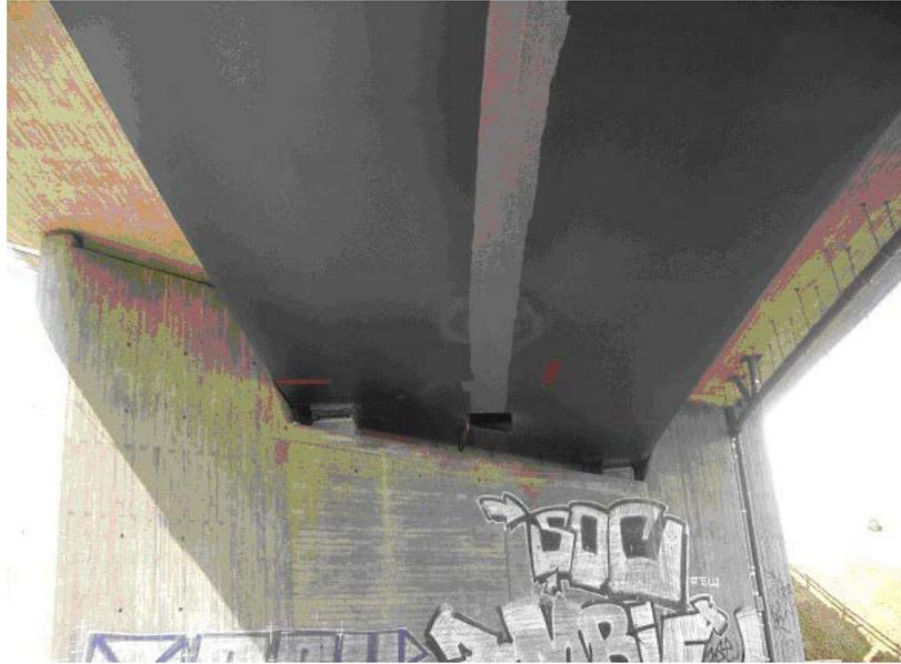
Bild 2.12.8: Bild zu geringer Abstand zwischen Bauteilen und angrenzenden Flächen
