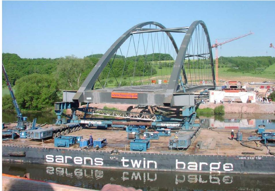
Bild 4.2.4: Längseinschub mit KAMAGS und Ponton Mainbrücke Marktheidenfeld
