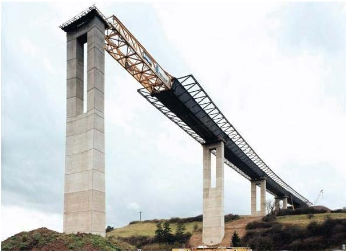
Bild 4.2.3: Taktschiebeverfahren Talbrücke Schwarzach
