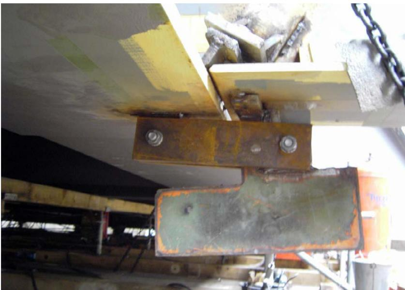
*Bild 2.12.17: Hilfsmittel zum Richten eines Montagestoßes*
