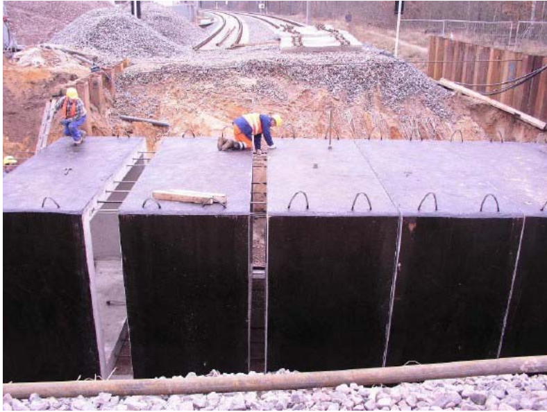
Abbildung 23 S-Bahn Rhein-Main – Rodgaustrecken EÜ Werner-von-Siemens-Straße, Unterführung in Fertigteilbauweise, Einschub der Einzelblöcke unter Vollsperrung in 2 Tagen
