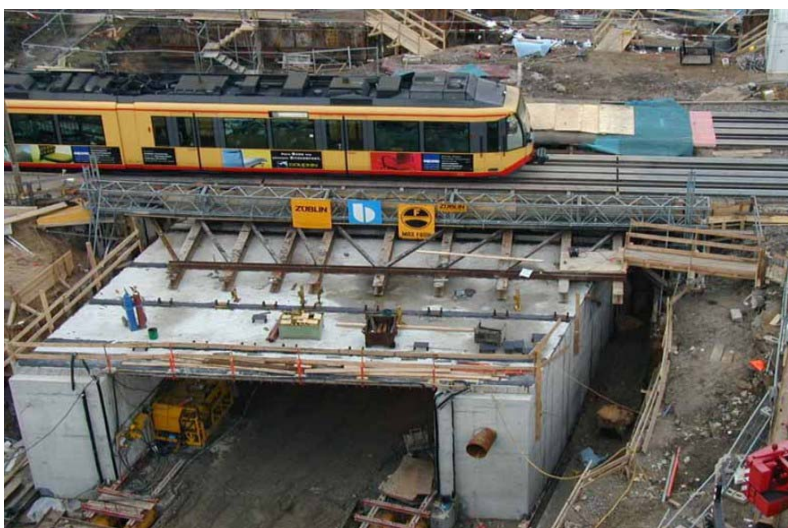
Abbildung 24 EÜ Weingarten, Gesamtübersicht während des Einpressvorgangs
