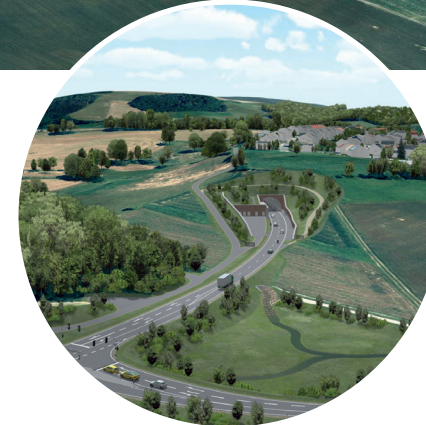
Tunnel Kisselhöhe Länge: 500 Meter
