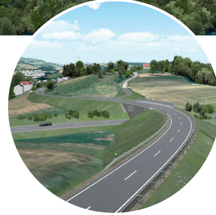
Überführung Panoramastraße Länge: 27 Meter
