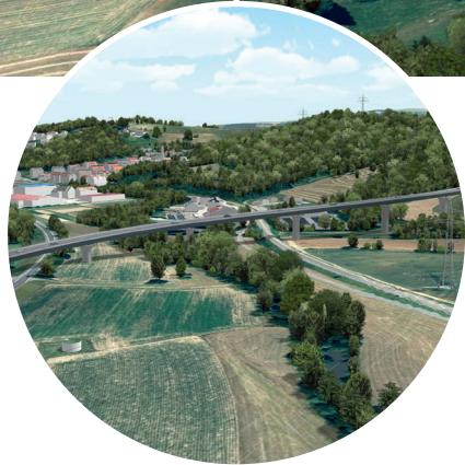
Talbrücke Reisen Länge: 400 Meter
