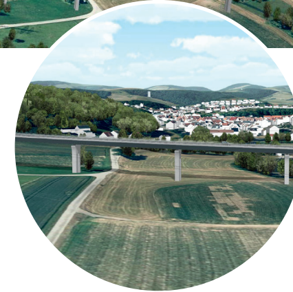
Talbrücke Mörtenbach Länge: 300 Meter
