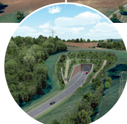
Tunnel Berkersklamm Länge: 380 Meter
