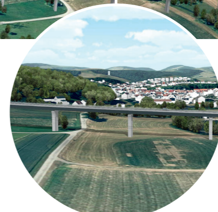
Talbrücke Mörlenbach Länge: 300 Meter
