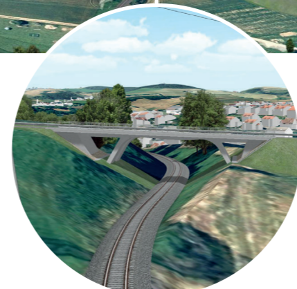
Unterführung Überwaldbahn Länge: 34 Meter
