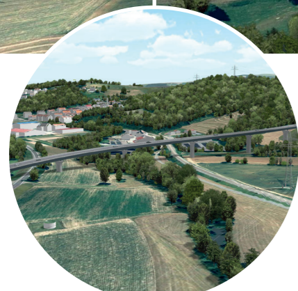
Talbrücke Reisen Länge: 400 Meter
